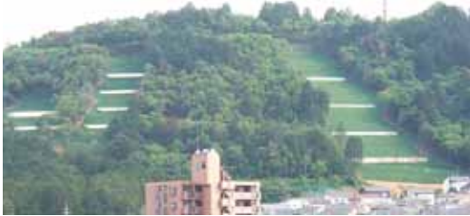
▲治山施設（山腹工）
