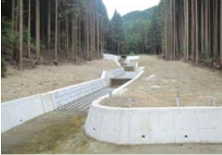
▲治山施設（流路工）
