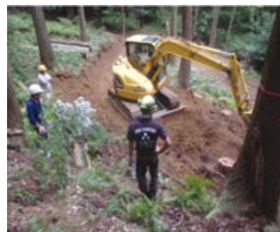
▲作業道作設オペレーター研修
