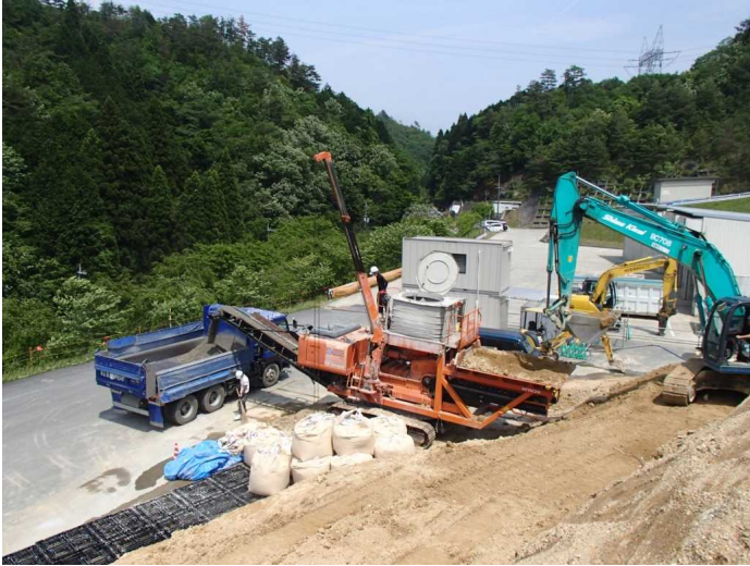
母材とセメントの機械混合の状況
