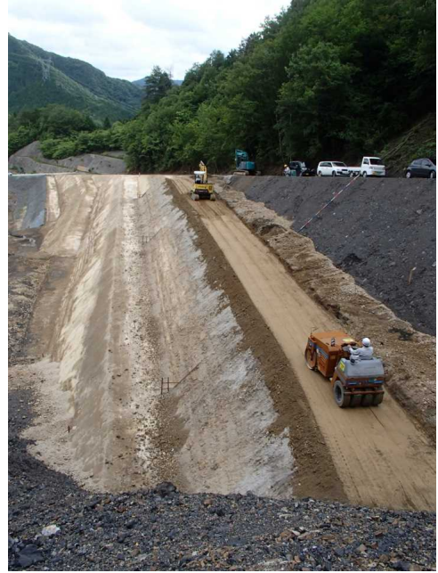
セメント改良土の転圧状況
