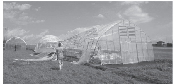
写真 2 台風により新設ハウスの 1/3 が倒壊
