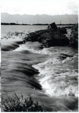
⑤決壊現場から井口を写す
