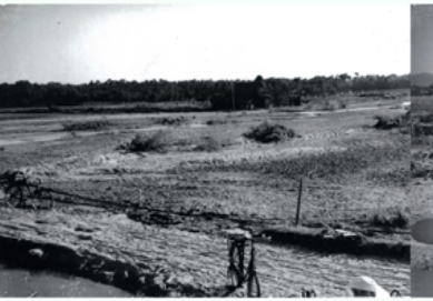
⑰井口より決壊後の現場
