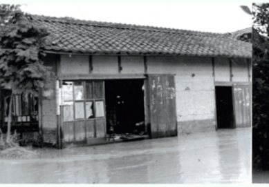
㉜五条 災害数日後、壁の濡れた跡
