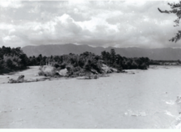
⑧決壊現場 上流より写す
