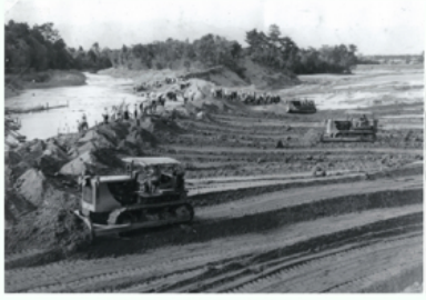
⑥決壊現場築堤中
