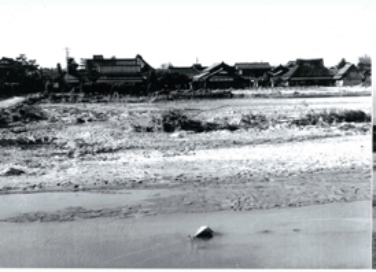
⑭井口災害現場から
