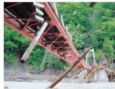
流木被害を受けたダムサイト人道橋【写真提供/室蘭開発建設部】
