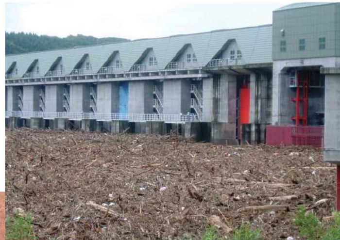
湖面を埋め尽くす流木【写真提供/室蘭開発建設部】
