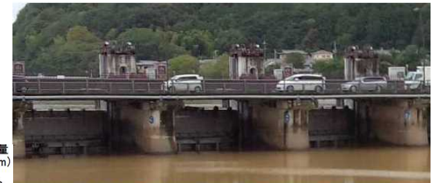
瀬田川洗堰全閉状況：下流右岸より撮影
