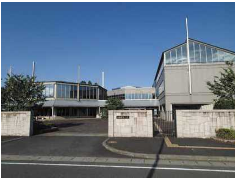
淡海環境プラザ外観
