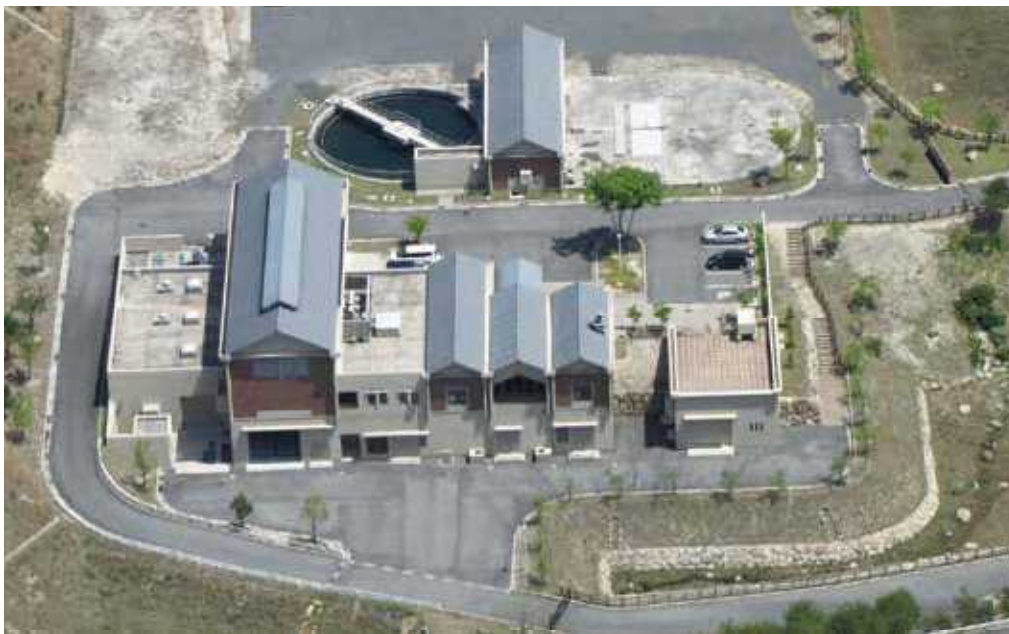
▲甲賀市信楽水再生センター
