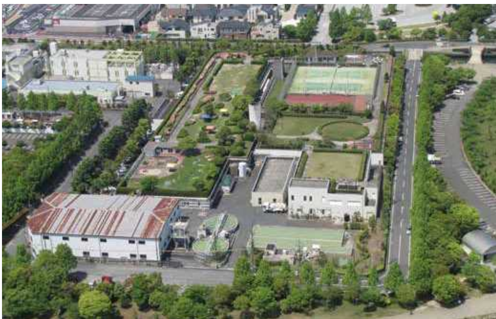
▲大津市水再生センター
