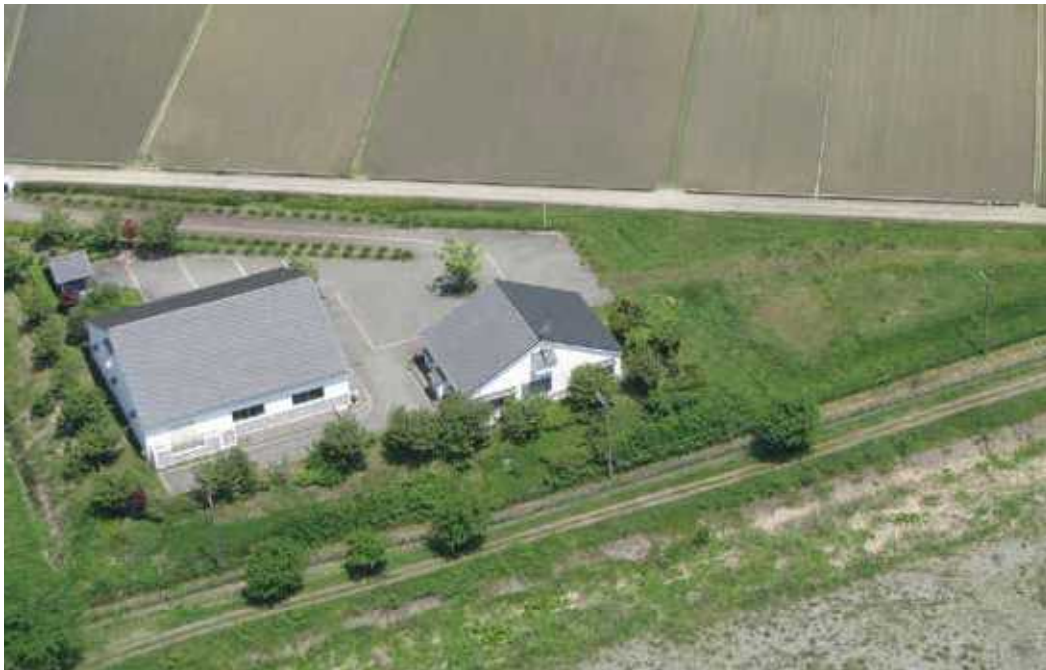
▲高島市朽木浄化センター
