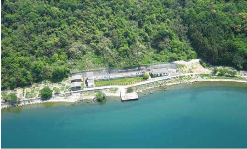
▲近江八幡市沖島浄化センター
