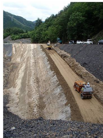
振動ローラーで転圧（他事例）
