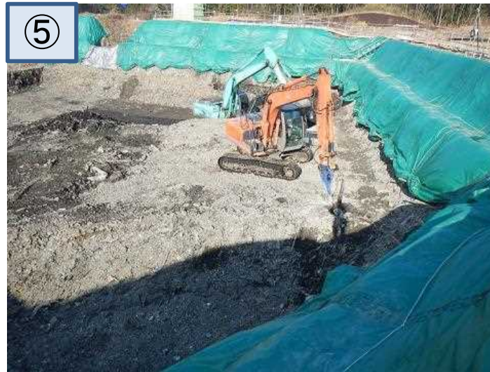
⑤ セメント混じり土掘削 118t
