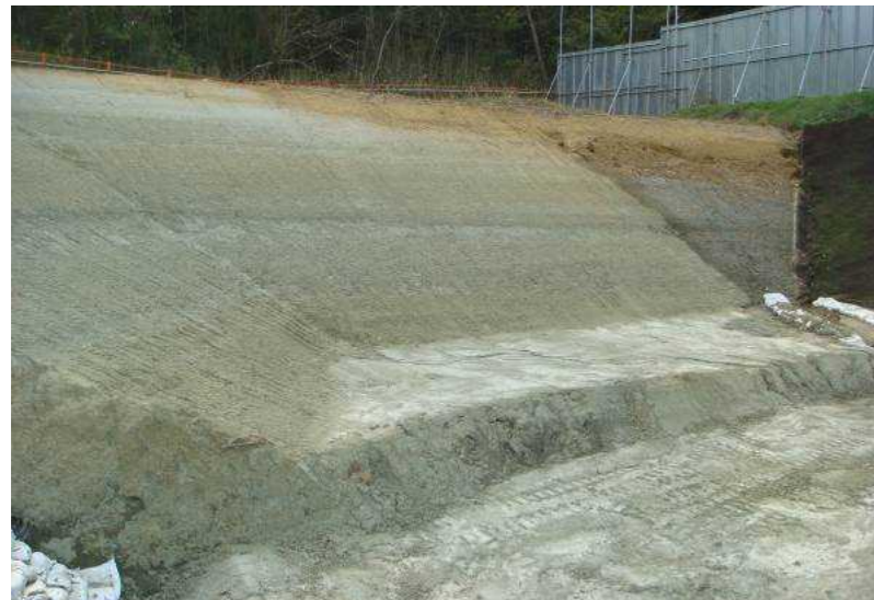
写真1 隣接地の国道工事現場に露出した古琵琶湖層群の粘土層（Kc5層） 整然と堆積しており、鏡肌を有するような断層粘土や地すべり粘土は認められない。
