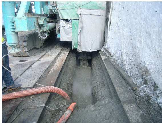
掘削・攪拌状況
