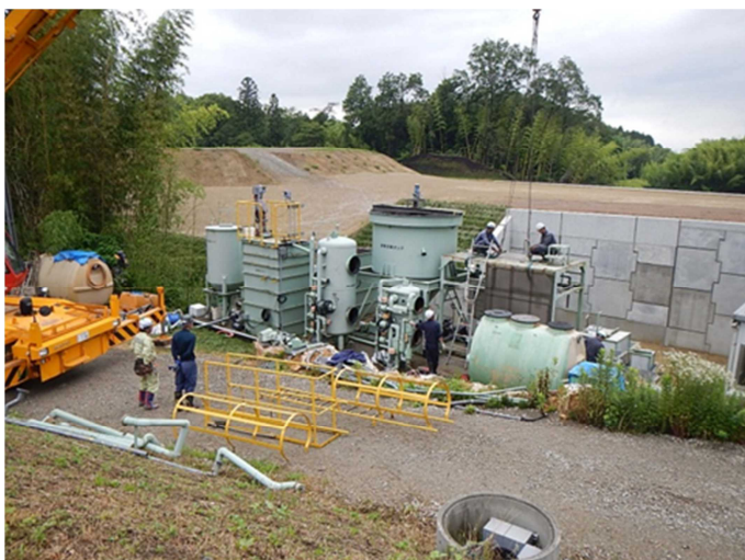
(旧施設 移設作業)
