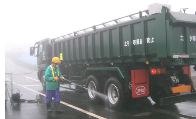
写真-4.4.5 廃棄物運搬車両の洗浄（天蓋付き車両）
