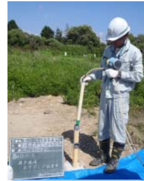
写真-2 水中ポンプの挿入状況
