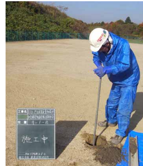
写真-1 ハンドオーガーの掘削状況
