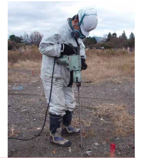
写真-3 ハンマードリルの掘削状況
