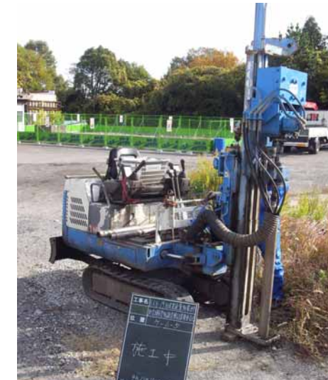
写真-2 掘削マシンの掘削状況
