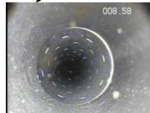
写真-2 周縁地下水: 県 No.1 の孔内状況 (H23 平均 SS: 180 (mg/L))
