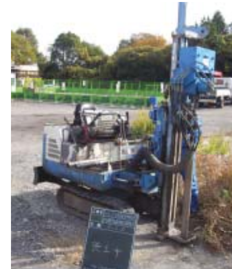
写真-2 掘削マシンの掘削状況
