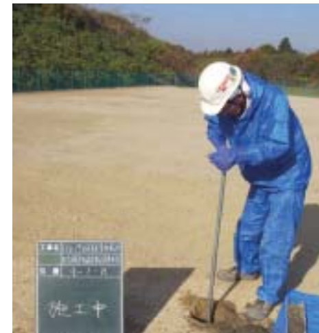
写真-1 ハンドオーガーの掘削状況
