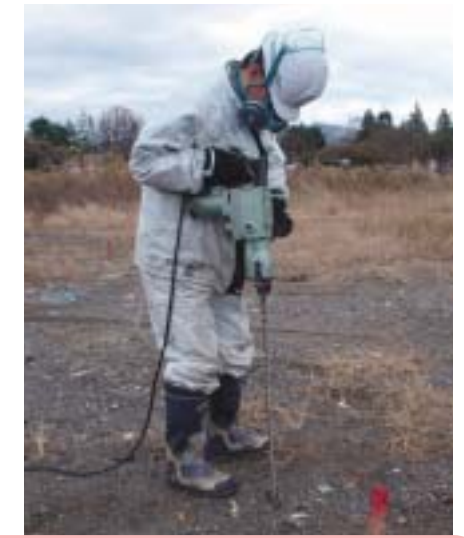
写真-3 ハンマードリルの掘削状況
