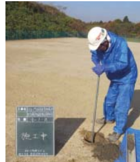
写真-1 ハンドオーガーの掘削状況
