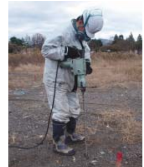
写真-3 ハンマードリルの掘削状況
