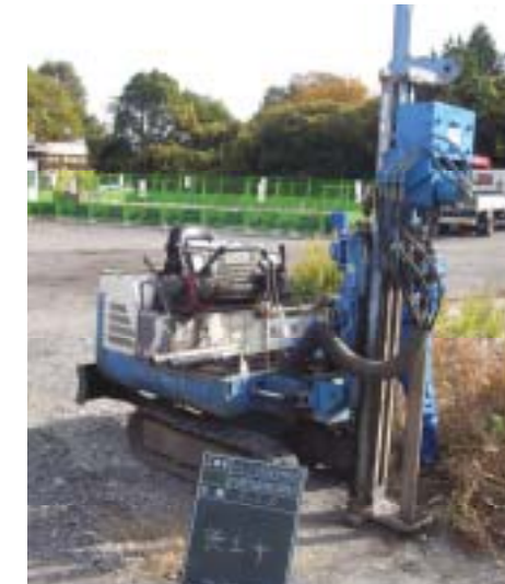
写真-2 掘削マシンの掘削状況
