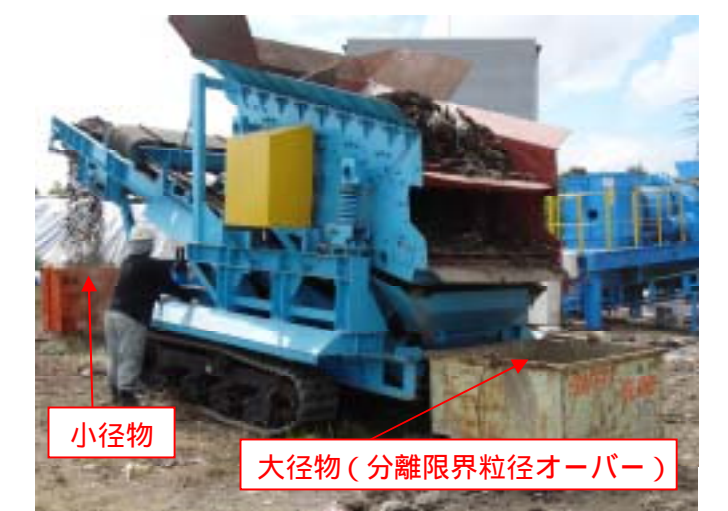
写真 1.2-7 振動篩による選別作業状況
