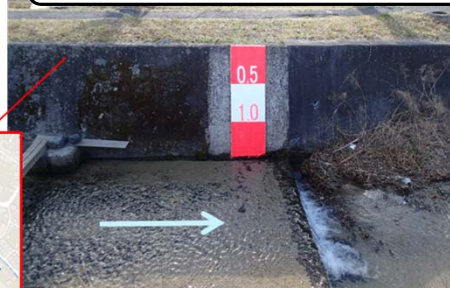
設置状況(落合川:広野川合流点)
