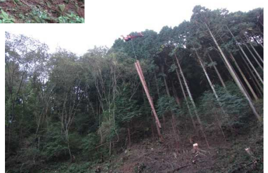
今回設置した架線による 搬出→
