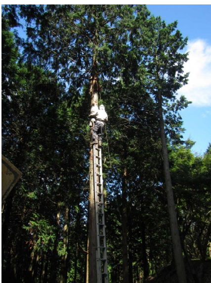
↑元柱に滑車を取り付けている所
