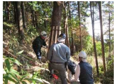
第2回1日目 滑車の設置
