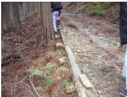
▲丸太による路肩補強
