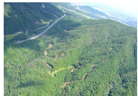
▲上空からの土石流発生状況(内畑町)
