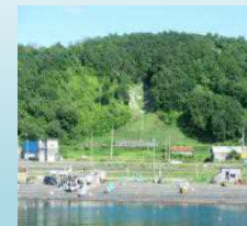
土砂崩壊防備保安林 (環境省HPより)
