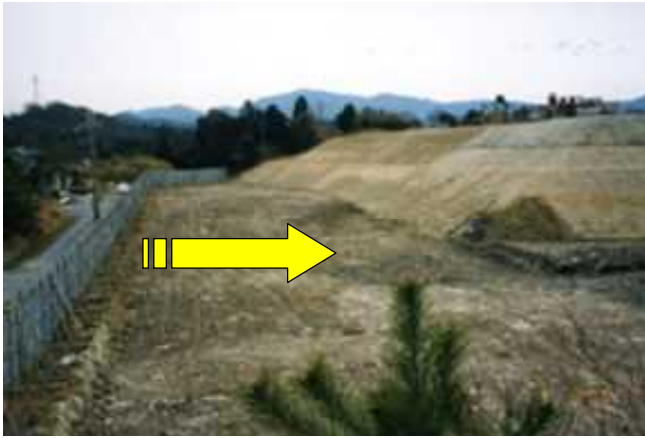
北尾団地側法面後退工事 (平成16年3月完了)
