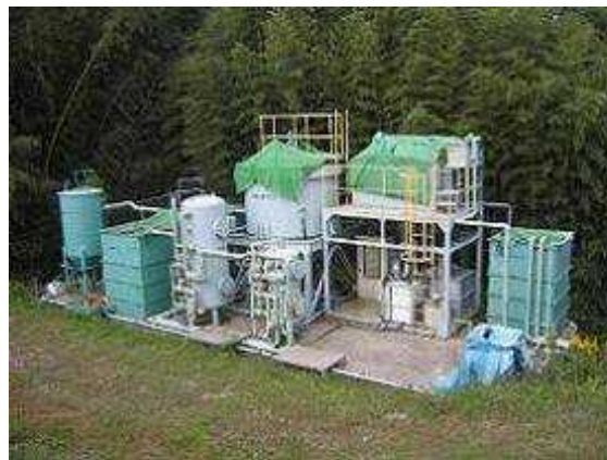
処理施設の設置 （平成 14 年 11 月完了）
