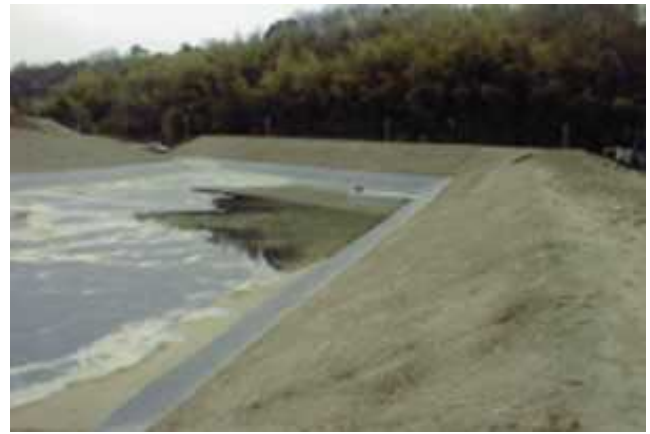
沈砂池の設置 (平成14年11月完了)
