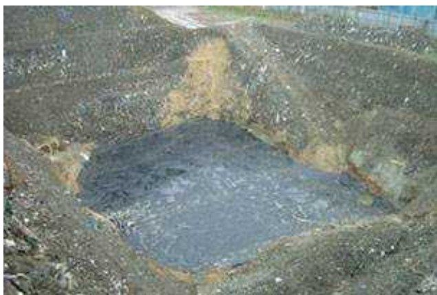
深掘箇所の是正（遮水シート敷設） （平成 17 年 6 月完了）
