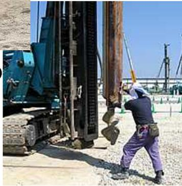
オーガ併用圧入工法 施工写真(例)
