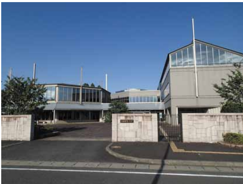
淡海環境プラザ外観
