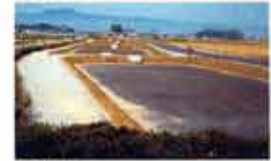
土壌浄化施設
