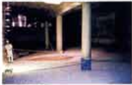
貯留兼沈殿池内部
