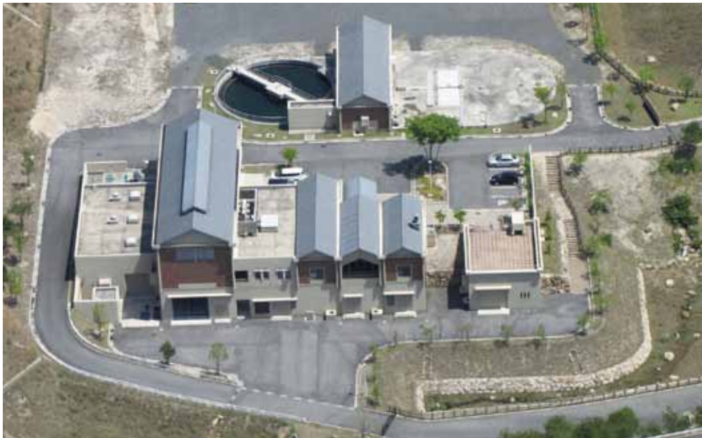
▲甲賀市信楽水再生センター
