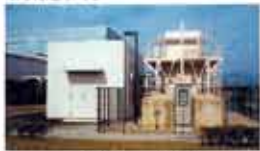
管理棟 除塵機
