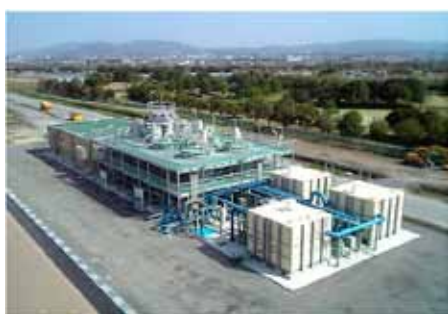
超高度処理実証施設(湖南中部浄化センター) 2,475m 3 /日
