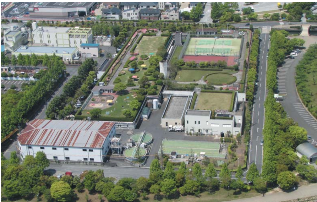
▲大津市水再生センター
