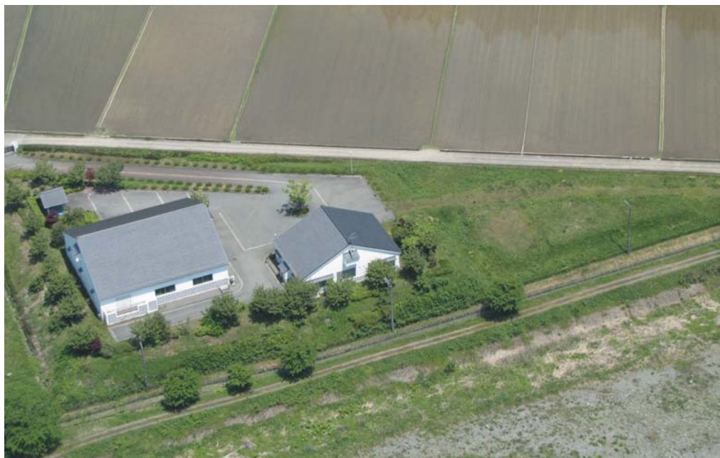
▲高島市朽木浄化センター
