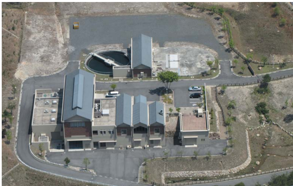
▲甲賀市信楽水再生センター
