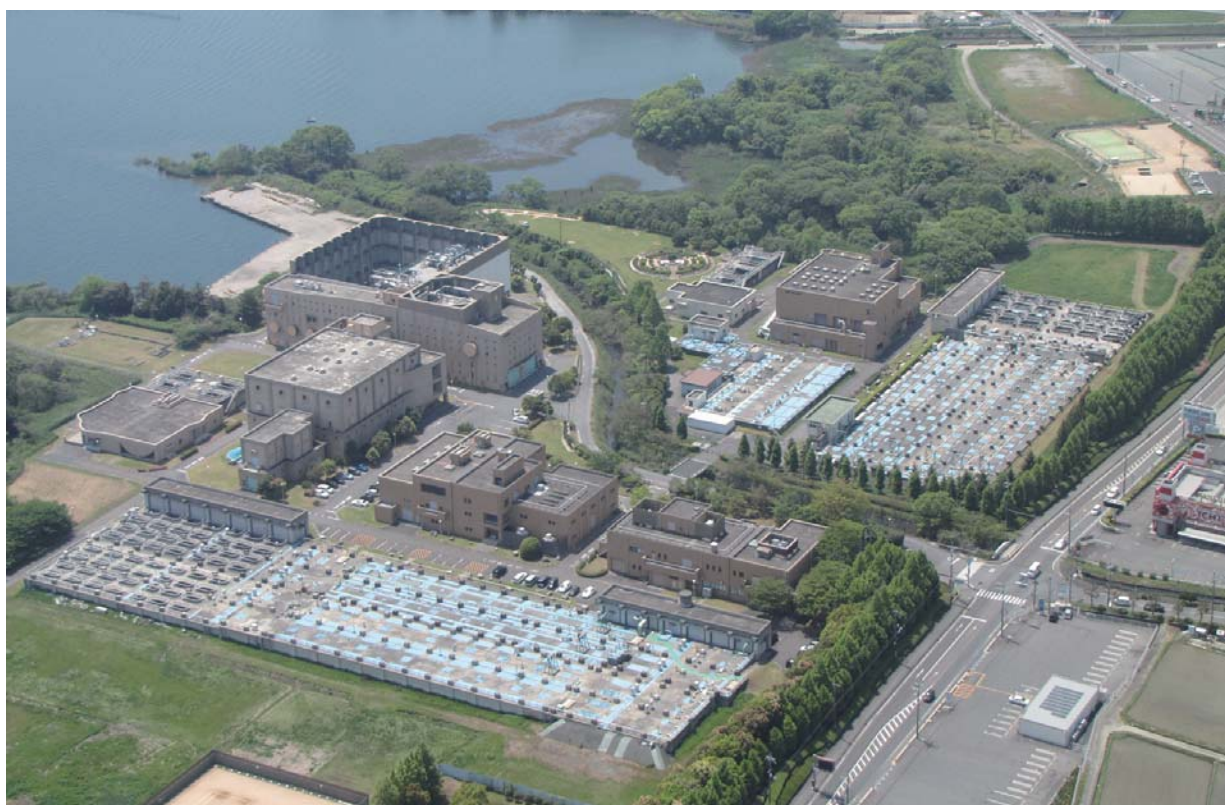
▲湖西浄化センター（大津市）
