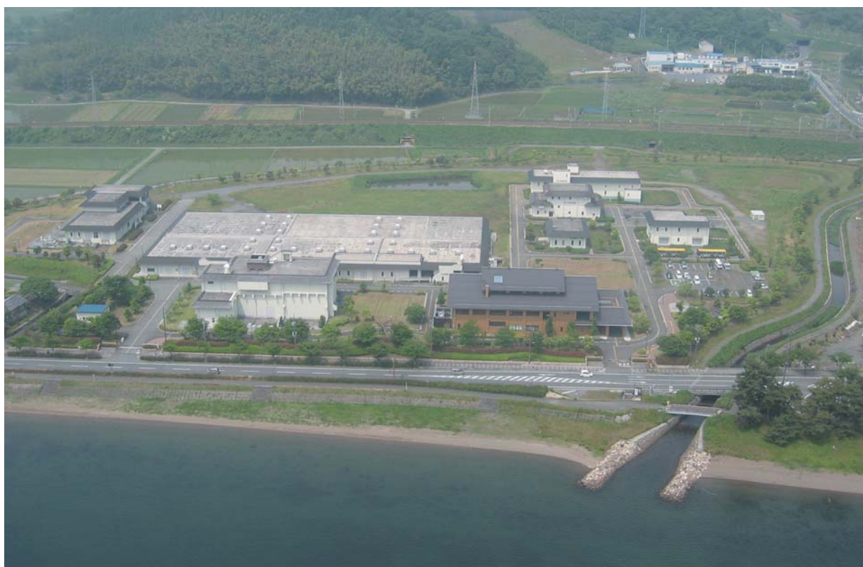
▲高島浄化センター（高島市）
