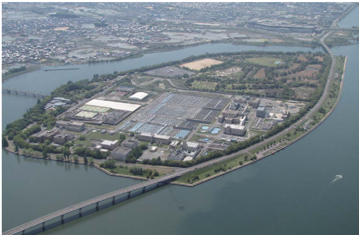
▲湖南中部浄化センター（草津市）
