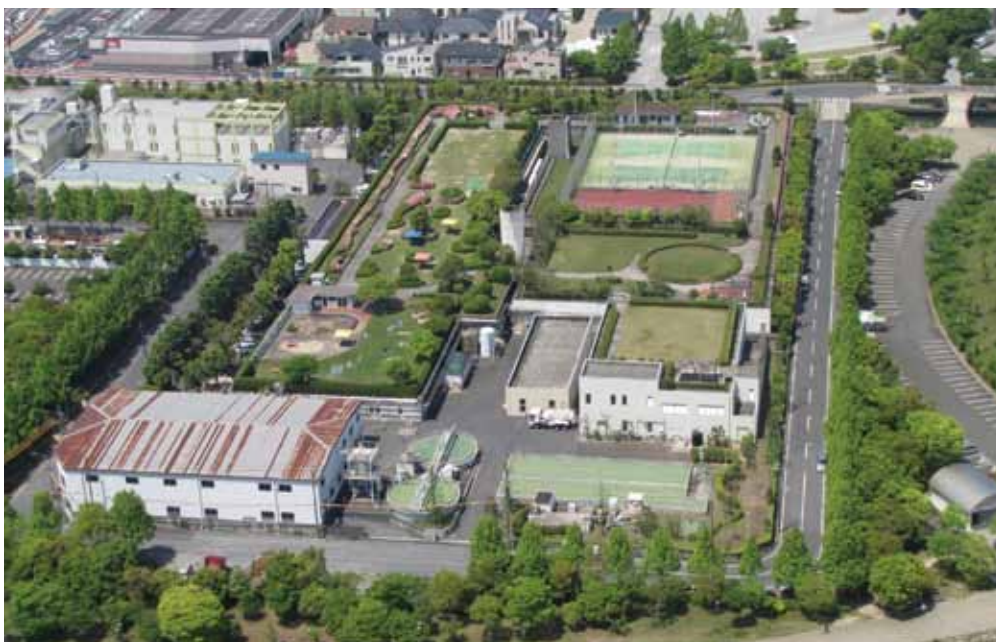
▲大津市水再生センター
