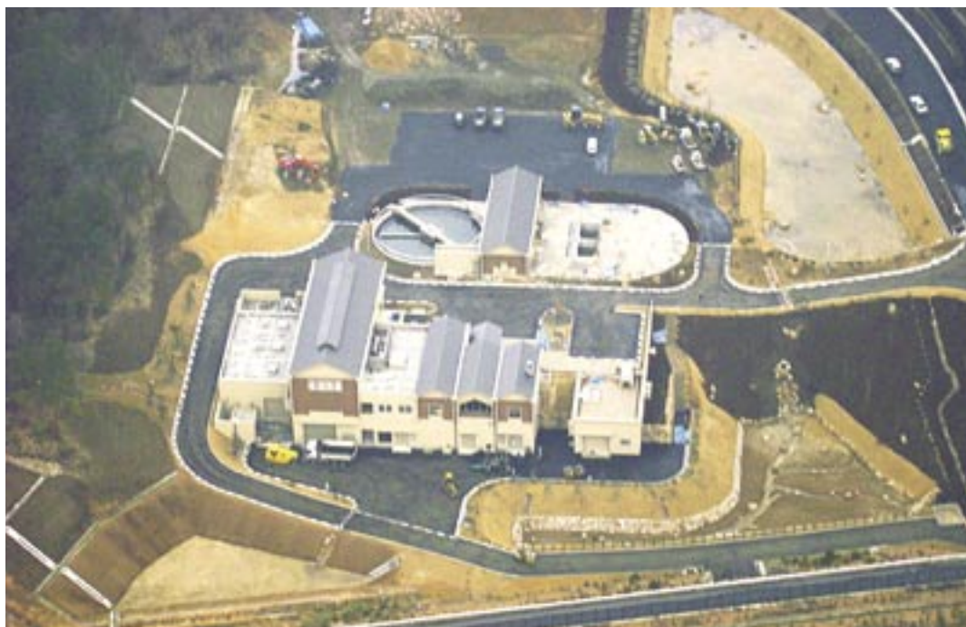
▲甲賀市信楽水再生センター
