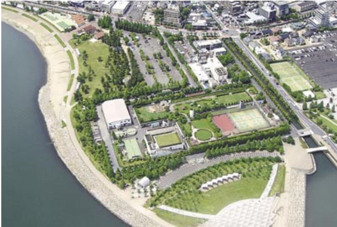
▲大津市水再生センター
