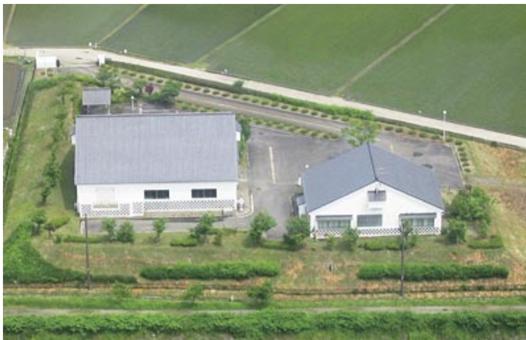
▲高島市朽木浄化センター
