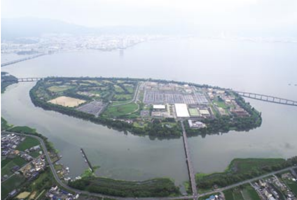
▲湖南中部浄化センター
