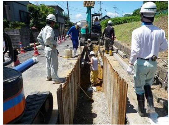
図 3-1-8. 下水管の布設状況
