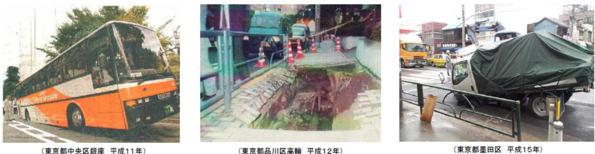
図 2-7. 管路施設が原因となった道路陥没事故の例
