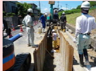
(下水管布設状況)
