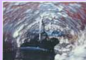
(油脂による管路閉塞)
