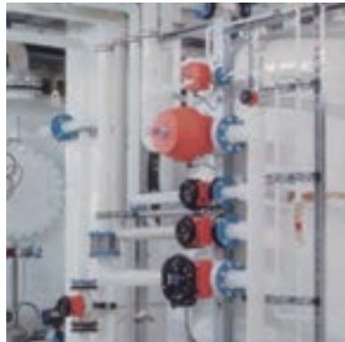
PVDFのプレハブ配管。PVDFは耐熱性や耐圧性、酸などの耐薬品性が高く、高寿命な材質。同材質による配管を製造している企業は少ない。
