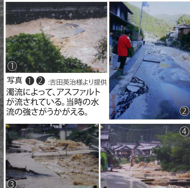
写真 ③④ :上丹生の皆様より提供 流木が12号橋によってせき止められている。これにより、ダムようになって、周辺は浸水してしまっている。
