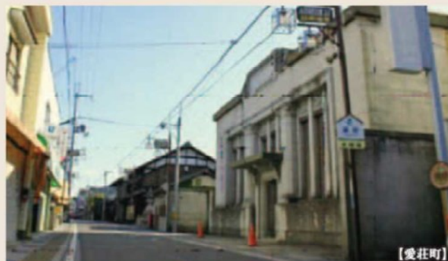
◎西洋建築と和風建築が建ち並ぶ景観
