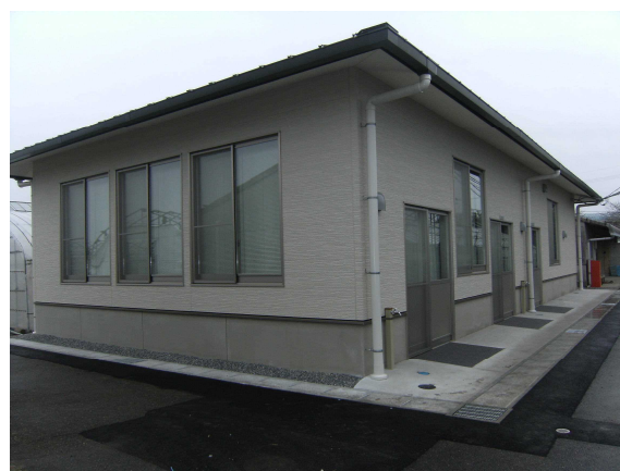
【ICT農業研修棟】本県のスマート農業推進拠点施設
