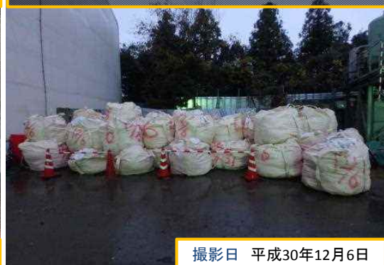
廃石綿等(保管状況)
