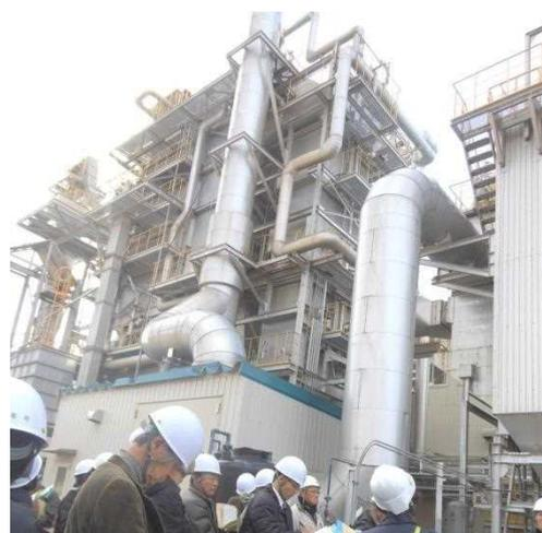
尽きてしまうような高い温度になっています。そして、炉の付近に通っている水を通した管を暖めて、水を高圧の蒸気に変えて、その蒸気がタービンを回すことで発電する仕組みになっています。煙に関しては、バグフィルタと呼ばれる設備でフィルタを通すことで 99%以上除去して、蒸気だけを大気に出しています。
