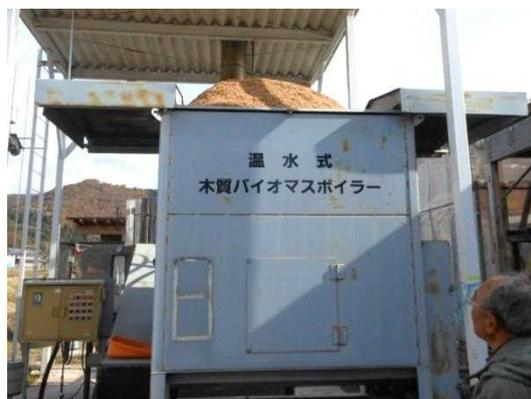
単な仕組みになっており、焼却炉のような形を想像いただければと思います。12時間の連続稼働が可能でして、手前の燃料が山盛り入った箱からコンベアで焼却炉に送り、連続的に燃焼させる仕組みになっています。ここでエラーが出た場合、携帯電話に連絡が来るようになっており、近くの従業員が見に来て対応することになっています。農業の方は化石燃料を使われることが多いと思いますが、我々は、木材からスタートしているグループ会社ですので、木にこだわりたいということで、木質の熱を利用しています。ここは、すごく寒い場所なので、ハウス内の温度を上げるのもたいへんな作業になります。温度調整がすごく難しいのですが、頑張っています。
