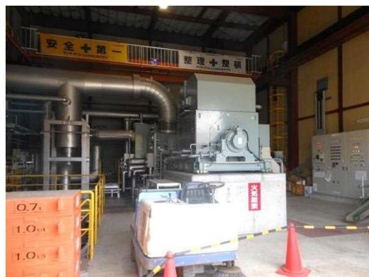
この発電所は、3550kw が最大出力になっていますが、この発電所を動かすための電力が 500kw 必要になります。残りを売電しています。3550kw といいますと、
