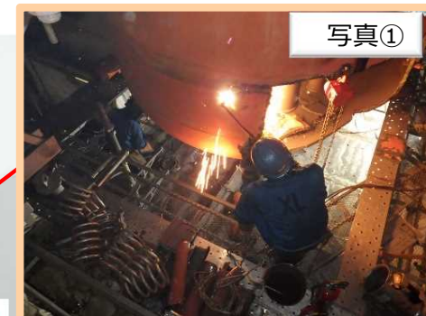
湿分分離器解体
