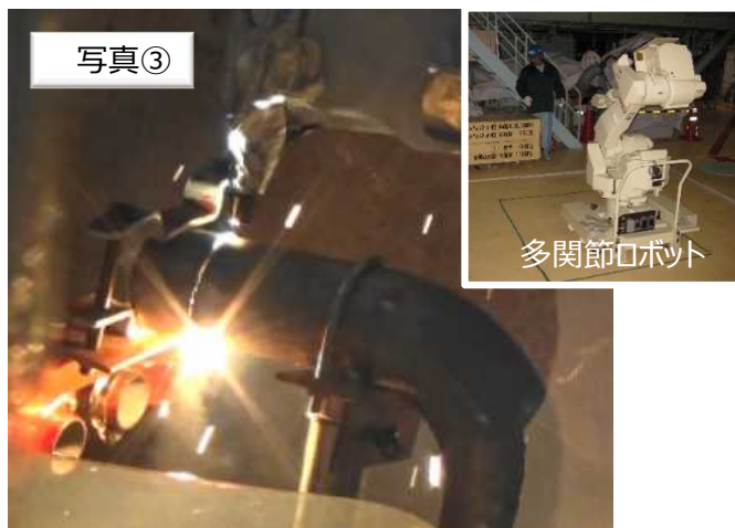
多関節ロボットによるレーザー切断実証
