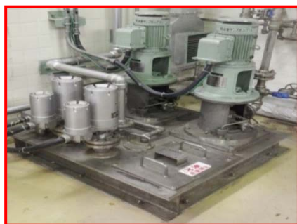
排水ピットの除染 (タービン建屋1階、H29.5.15～6.9)
