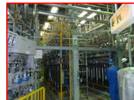
制御棒駆動水圧ユニット解体 (原子炉建屋1階、H29下期～)
