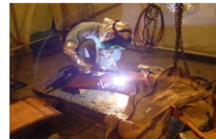
管理区域内での撤去物小割作業の様子（その2）
