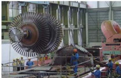
低圧タービンローター撤去作業の様子
