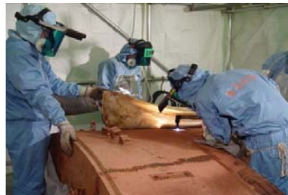
管理区域内での撤去物小割作業の様子（その1）
