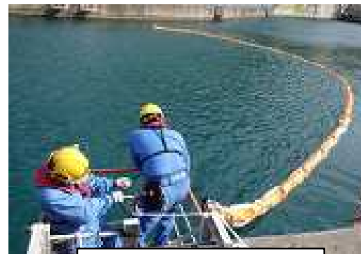
シルトフェンス設置
