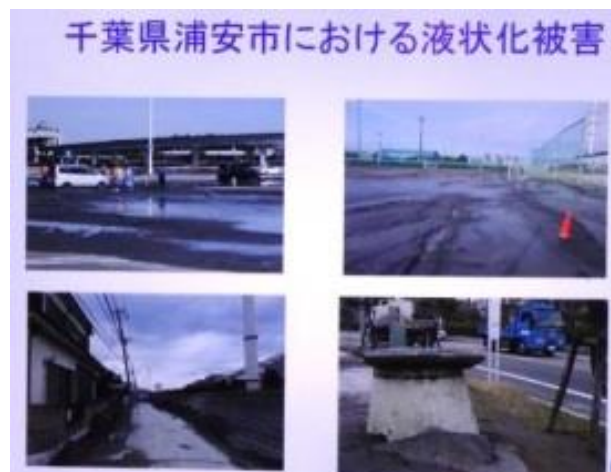
東日本大震災時の浦安市での液状化の様子
