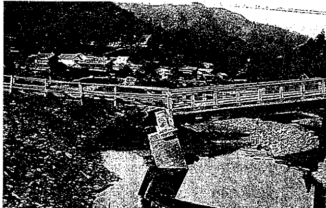
橋脚が洗掘され沈下(朽木村)
