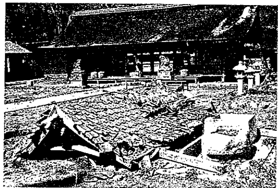
豊満神社の手水場の倒壊(愛知川町)
