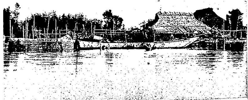
琵琶湖洪水の被害で首まで水がきている(草津市)
