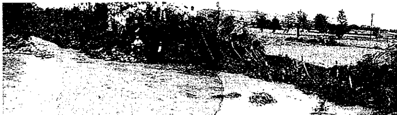
堤防を大部分洗掘(八日市市)
